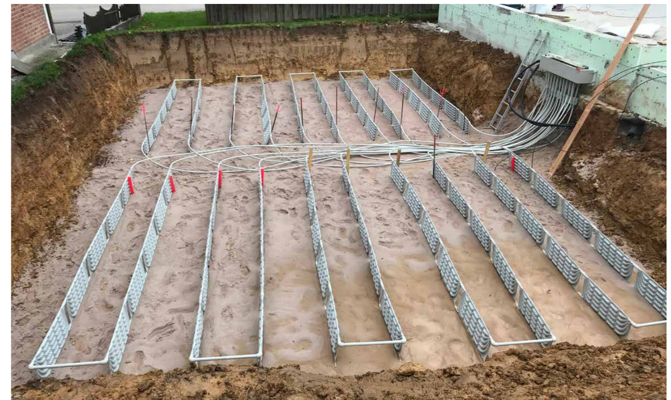
Bau einer GeoCollect - Anlage
